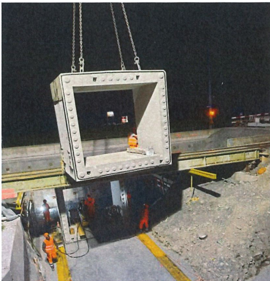
Einbau der PU-Elemente am Bahnhof Schiers
